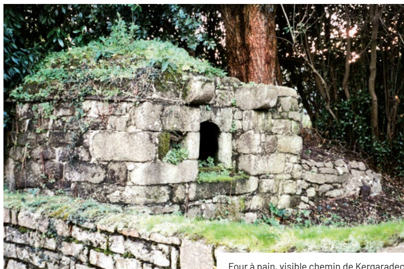
Four à pain, visible chemin de Kergaradec.
